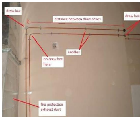
Conduit Wiring(concealed conduit wiring)
